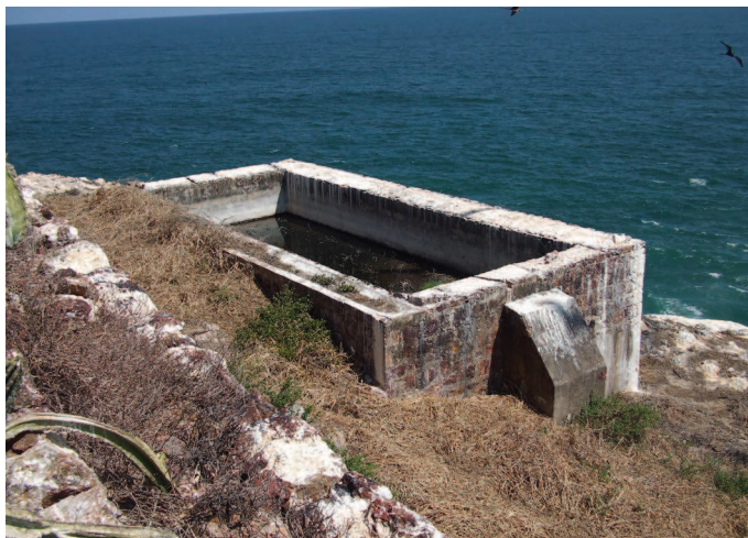
Citerne de la plate-forme inférieure
