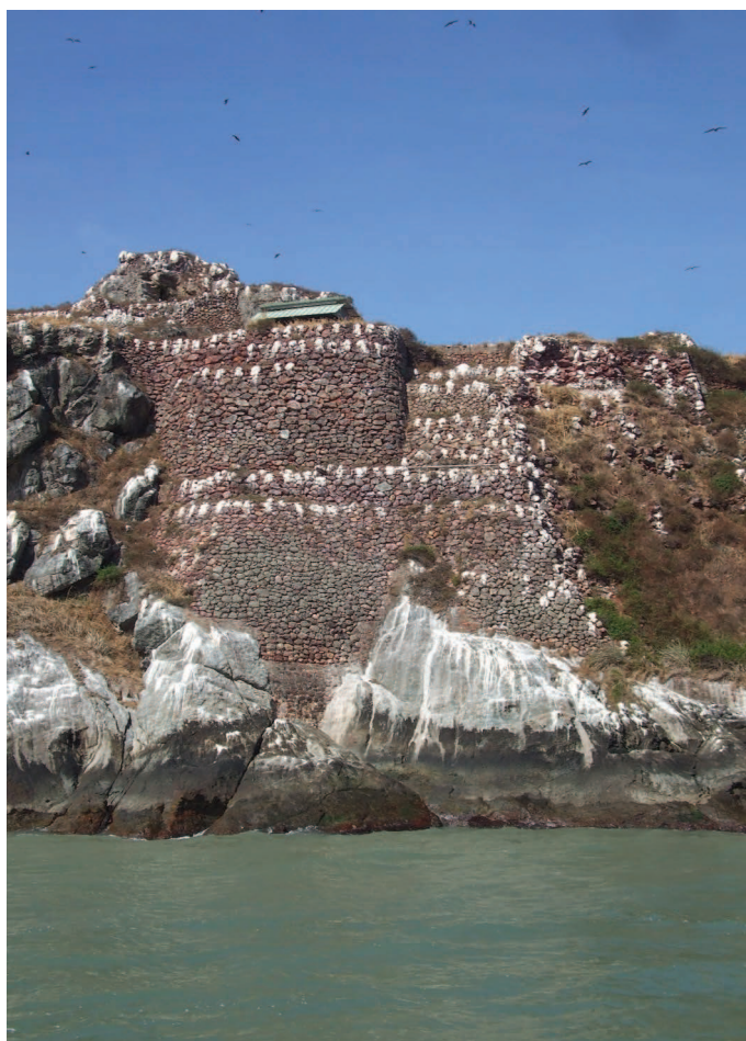
Vue d'ensemble de la zone de départ des bennes, avec un important ouvrage de soutènement muraillé
