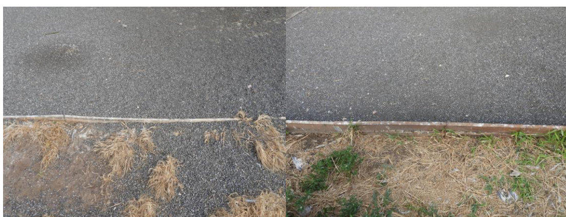
Figure 16 : Bordure de plateforme après la saison de reproduction, en 2024 à gauche, et 2025 à droite (avec la réhausse de coffrage)
